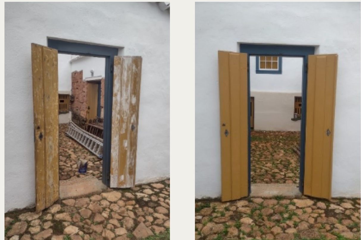
FIGURA 6 - Antes e Depois entrada Área de serviço do Museu Padre Toledo após revitalização
