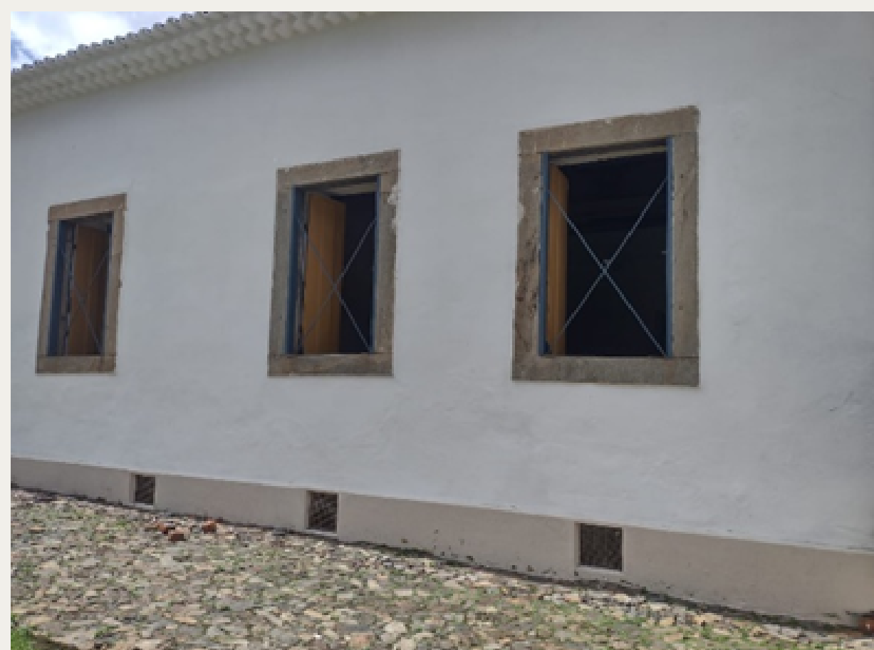
FIGURA 7- Obra de Revitalização Museu Casa Padre Toledo
